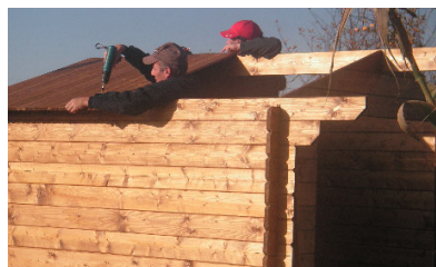
Bau unseres Gartenhauses
